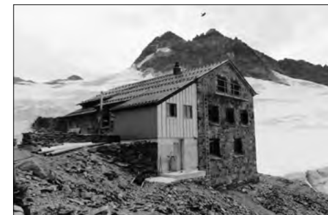
Mutthornhütte 2019 mit neuem Sanitär-Anbau.
