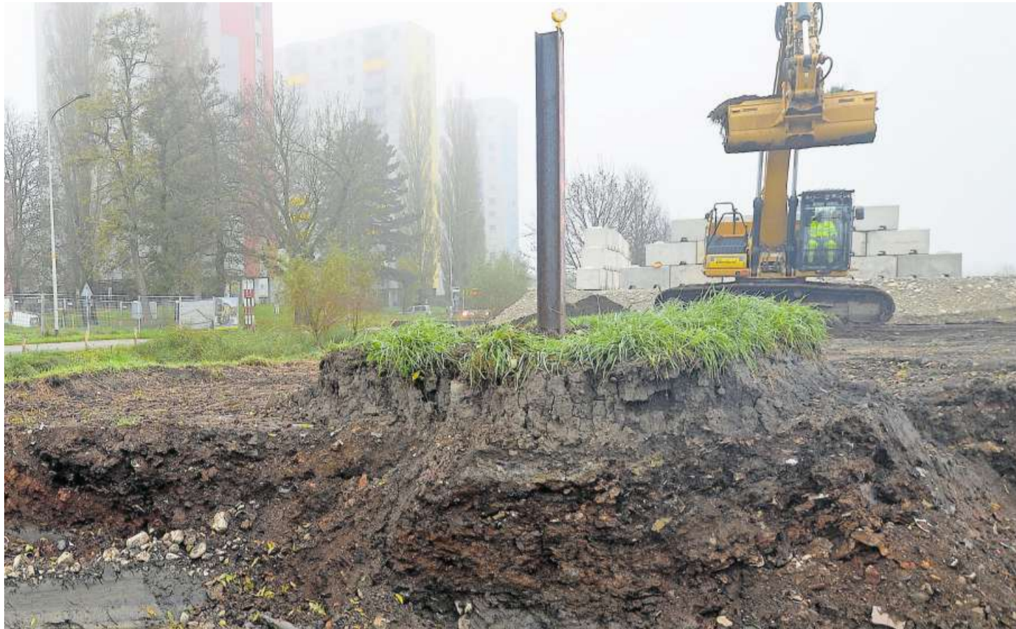
Derzeit läuft im Gebiet Weitblick die Sanierung des Stadtmistes.
