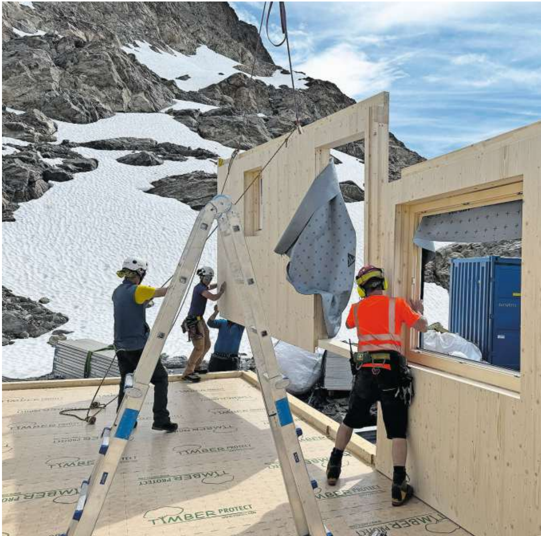
Blitzschnell wurde die Hütte aufgerichtet.
